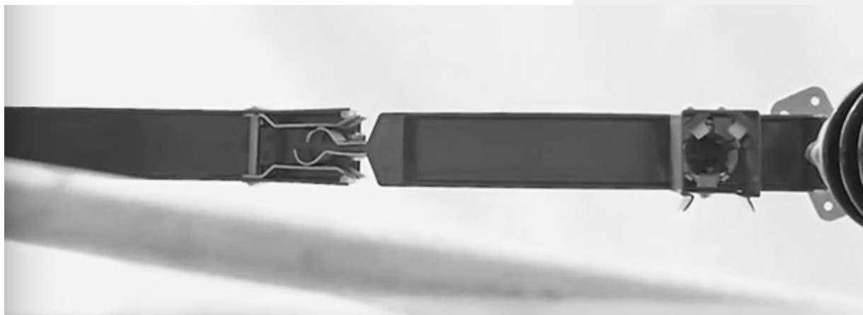
Рис. 18. Правильное положение токопровода разъединителя
